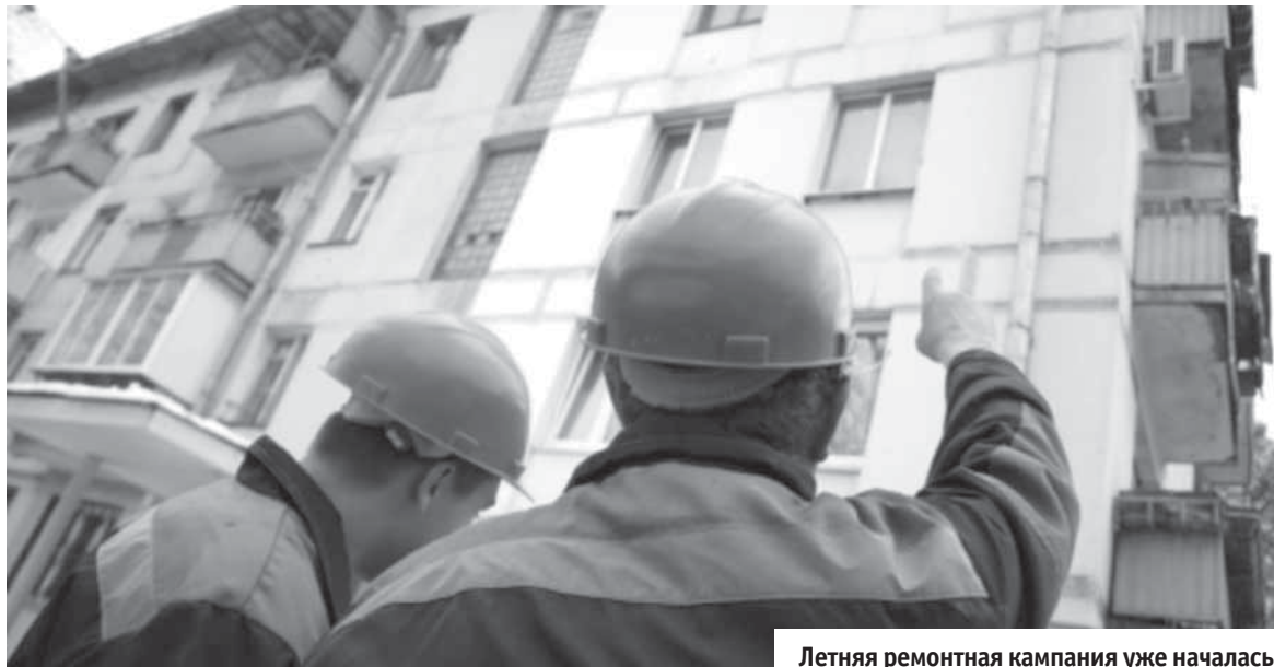
Летняя ремонтная кампания уже началась
