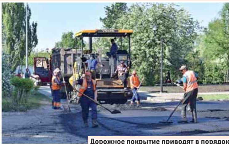
Дорожное покрытие приводят в порядок
