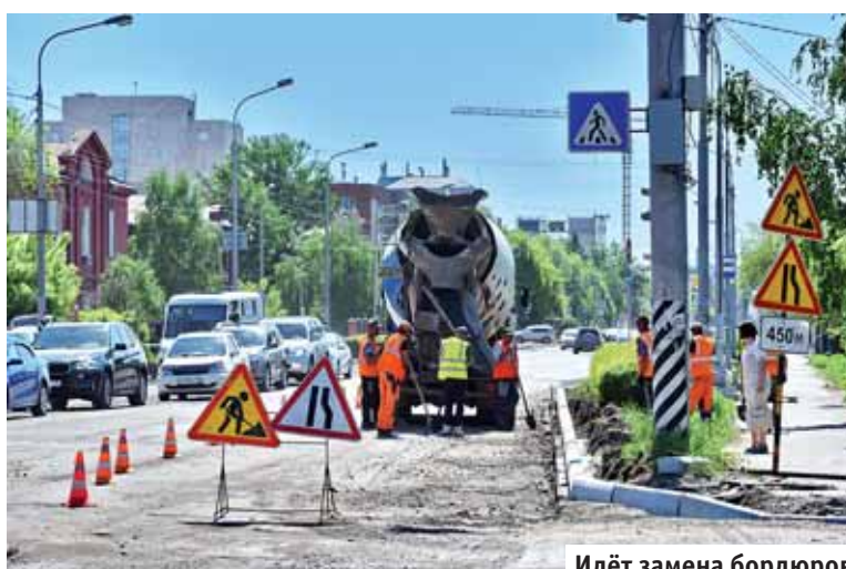
Идёт замена бордюров
