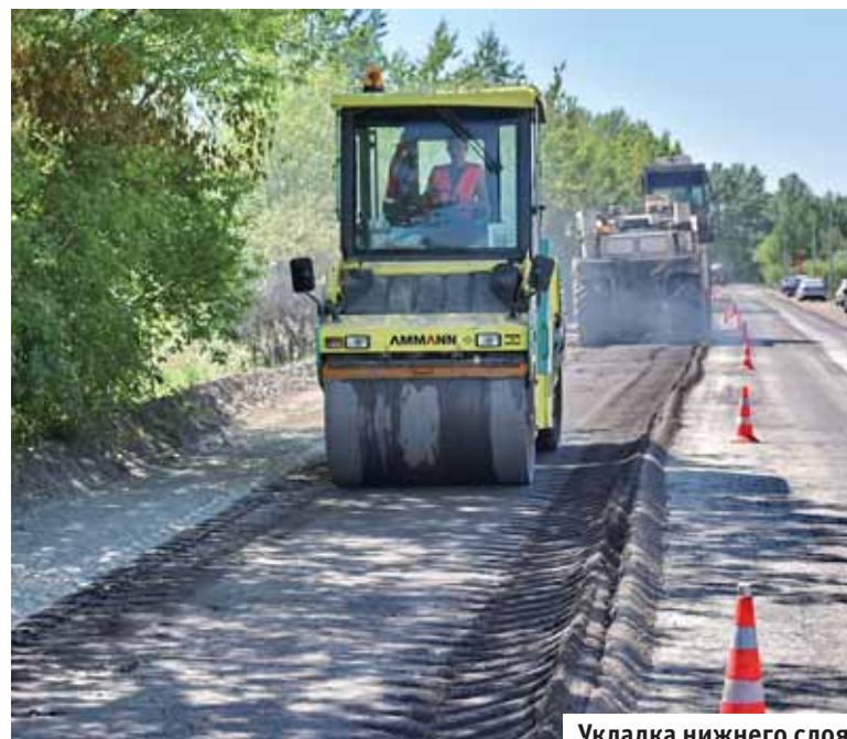
Укладка нижнего слоя
